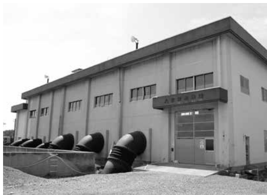
八沢浦排水機場
