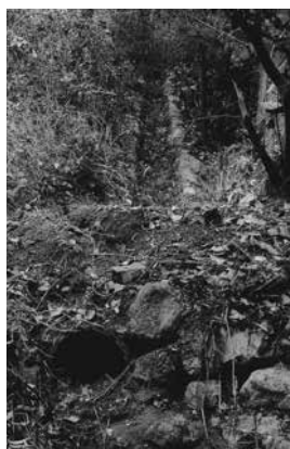
導水用の土管
