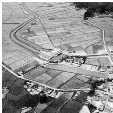
八沢地区遠景下流側より
