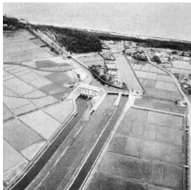
八沢地区遠景上流側より
