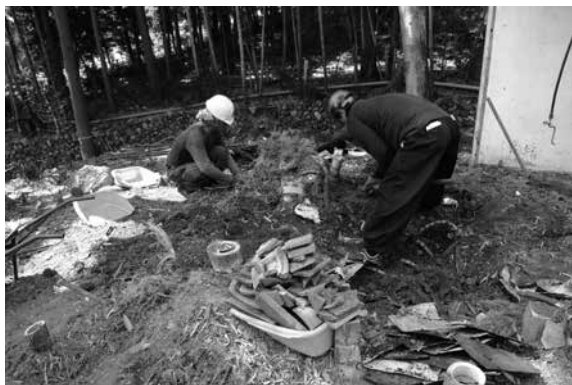
墳頂部家屋解体作業風景
