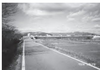
⑦ 藤井ハウス工場北の道路から 新設道路に架かる橋
