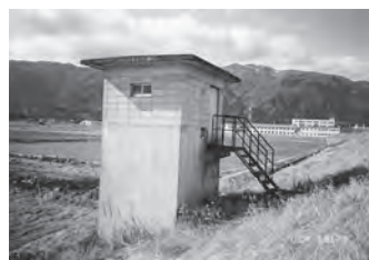
⑥ 金草川ファブリダム堤防脇
