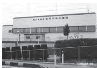
⑩ 烏江・金草川排水機場
