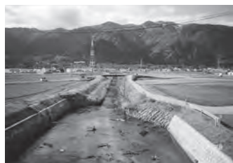
⑧ 新設道路上よりあほよげ堤を望む 藤井ハウス工場の西側あたりより
