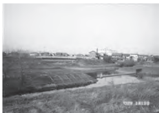
⑭ 排水機場への入口をみる
