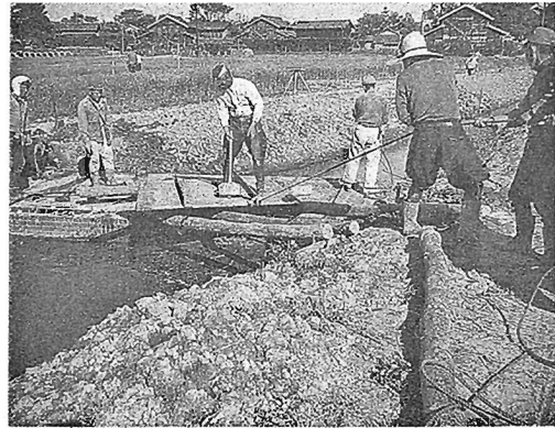
▲ 工事のようす（船附地内）
