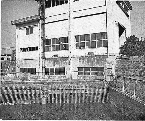
▲ 大野にある五三排水機場
