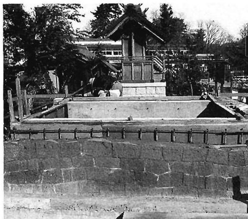
本殿基礎工事
