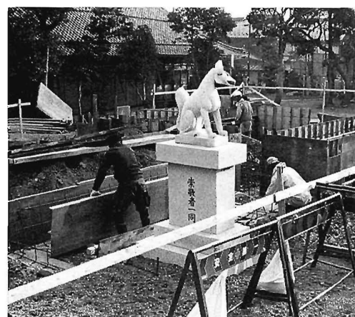
幣殿・拝殿基礎工事
