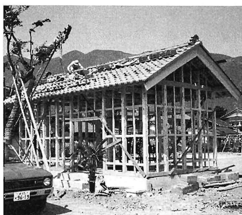
神庫再建工事中
