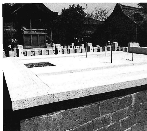
本殿基礎工事
