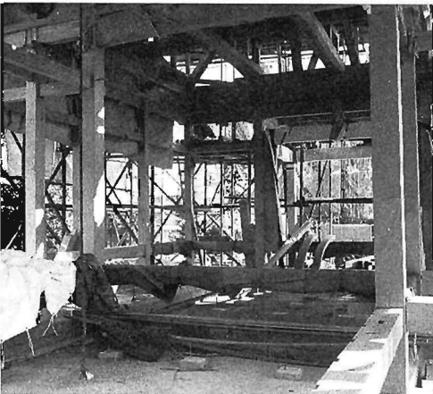
社殿建設工事
