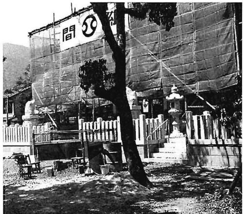
社殿建設工事
