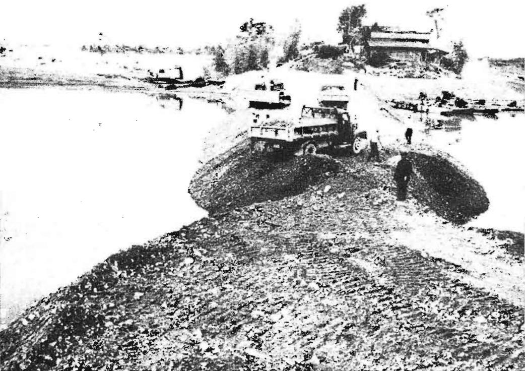
再度決壊した牧田川右岸堤防は 昼夜をわかたぬ突貫作業の結果 10月10日ようやく仮締切堤防工事に成功した
