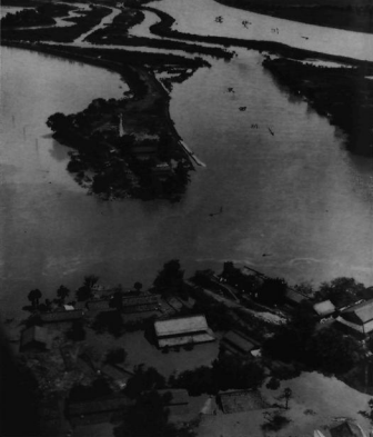
昭和34. 8. 12-14 台風第7号被害 牧田川決壊現場(横古地)の航空写真 (毎日新聞社提供)
