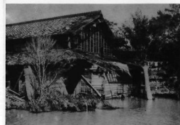
瓦は飛び壁は落ち廃屋となった
