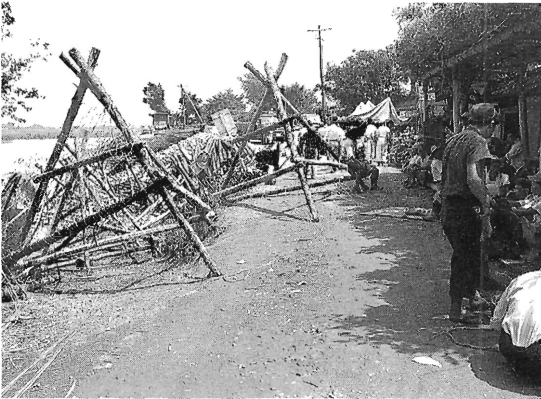
堤防補強工事（根古地）
